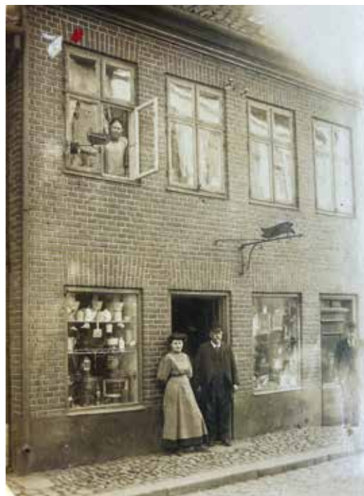
Foto fra omkring 1906, hvor man i dørråbningen til domicilet Stengade 64 ser William Harald Adolf Olsen sammen med datteren Helga. Skibslanterner var Olsens speciale, og han fik i 1880 patent på tågehorn. Han er født i Helsingør og fik borgerskab som såvel blikkenslager som marskandiser.
